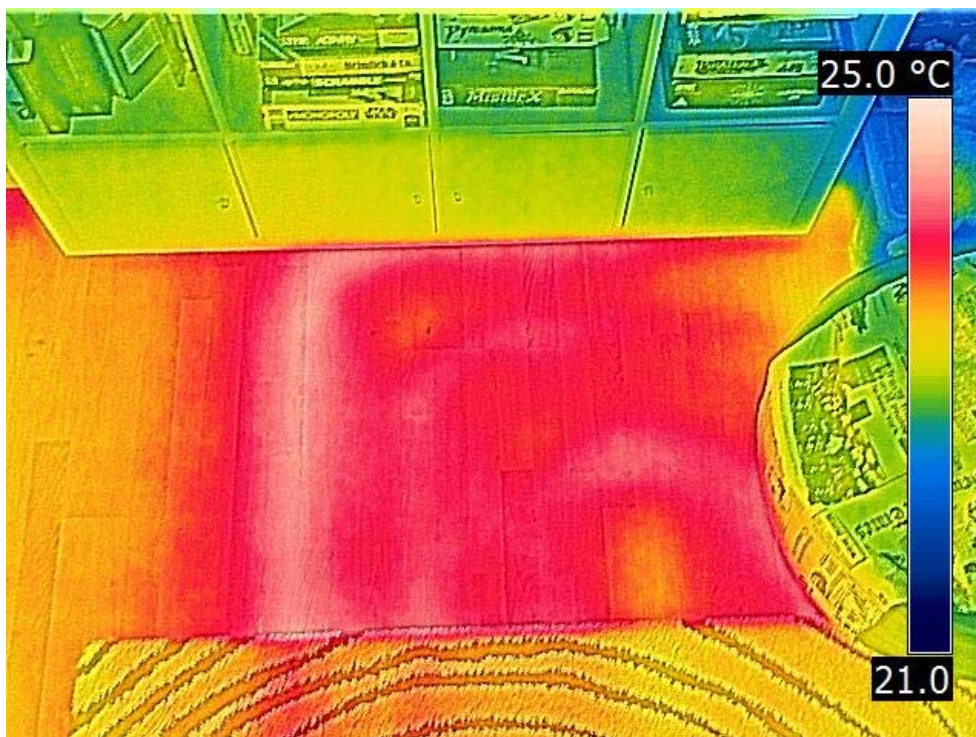
Abb.: 17.: Qualitätskontrolle an einer Fußbodenheizung; Position und Abstand der Heizungsleitung sind gut zu erkennen.
