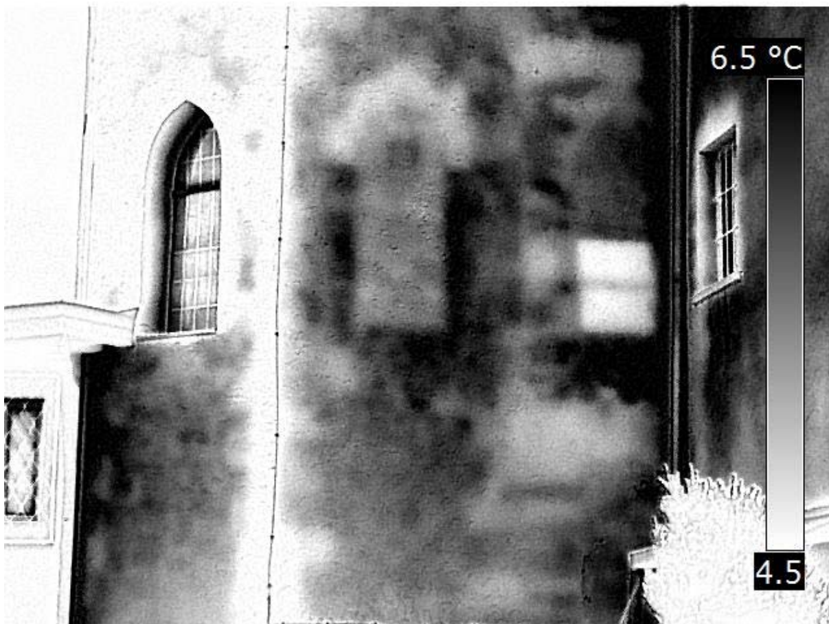
Abb.: 23.: Schloss Schernberg, beheizte Innenräume: Neben dem vermauerten gotischen Fenster zeigt sich auch rechteckige Öffnungen.
