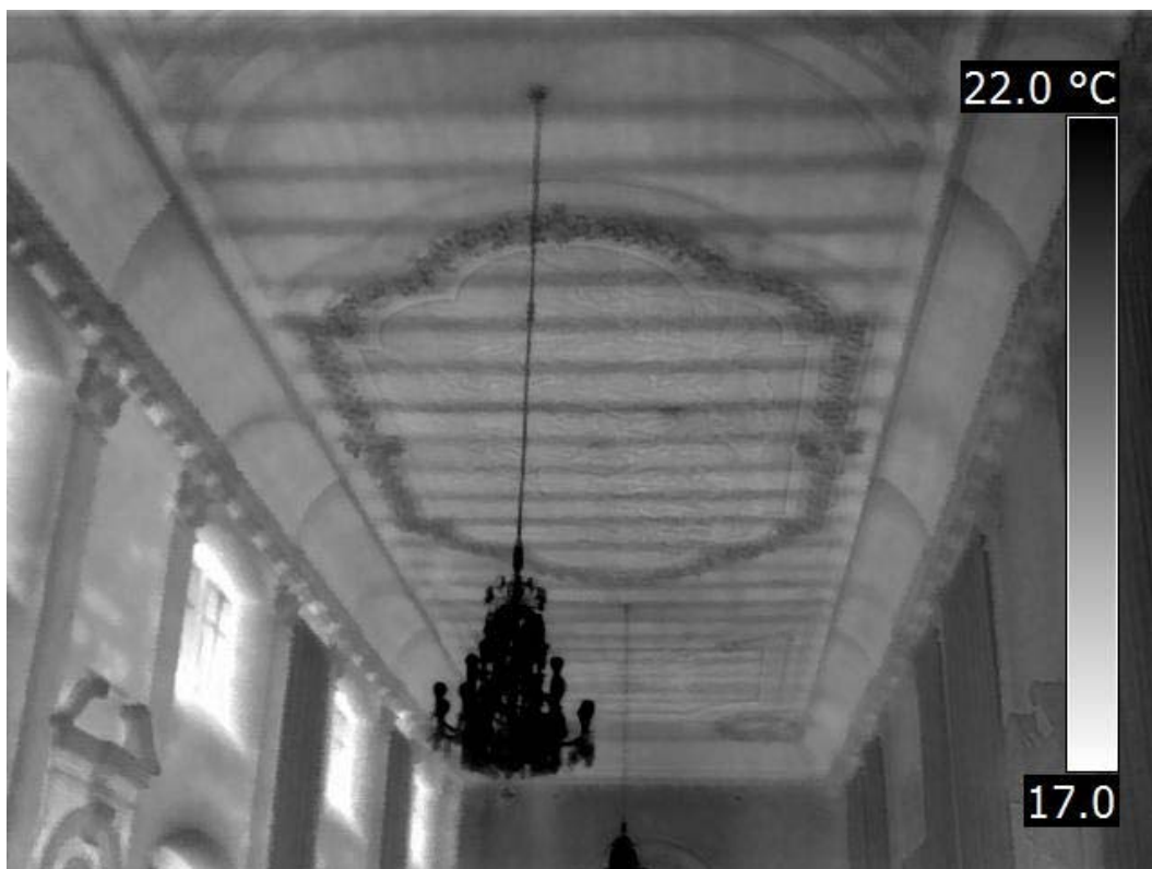
Abb.: 26.: Residenz Salzburg Innenraum zu unbeheiztem Dachboden,: Trambalken zeichnen sich an der Decke des Karabinierisaal ab.
