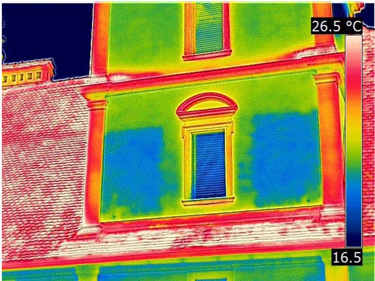
Abb.: 27.: Schloss Eggenberg, unbeheiztes Mauerwerk: Am Mittelturm wird die Grenze zwischen mittelalterlichem Mischmauerwerk und barockem Ziegelverband sichtbar.
