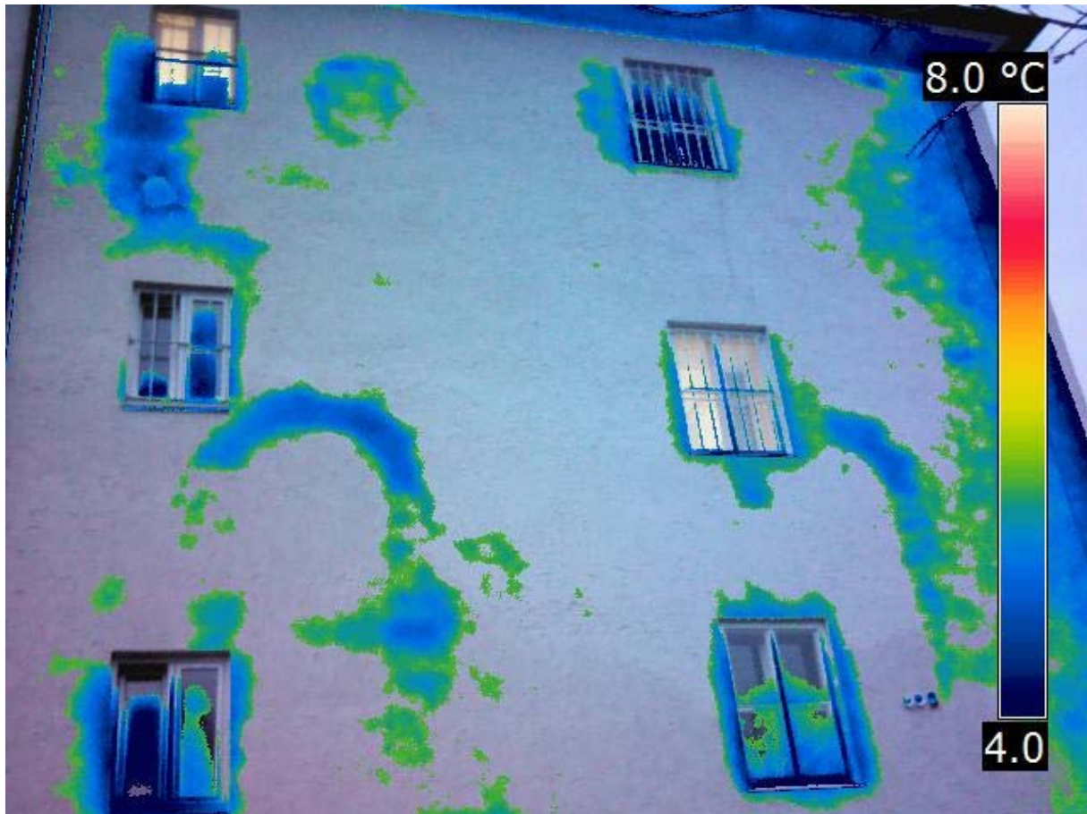
Abb.: 24.: Schloss Schernberg, beheizte Innenräume: Unter dem Putz der Aussenfassade zeichnen sich vermauerte Bogenfenster ab.
