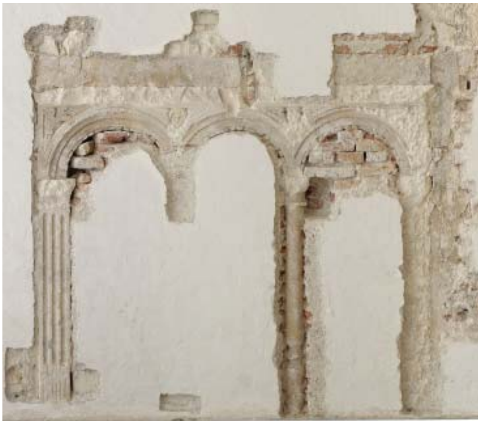
Abb.: 30.: Schloss Eggenberg: Dreibogiges Renaissancefensters nach der Freilegung.
